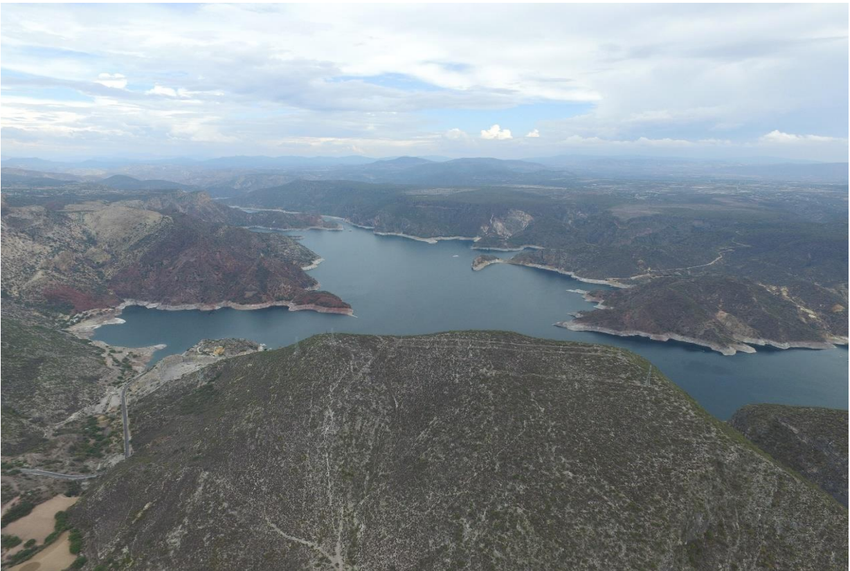
Figura 4. Vista aérea de la presa Zimapán.
